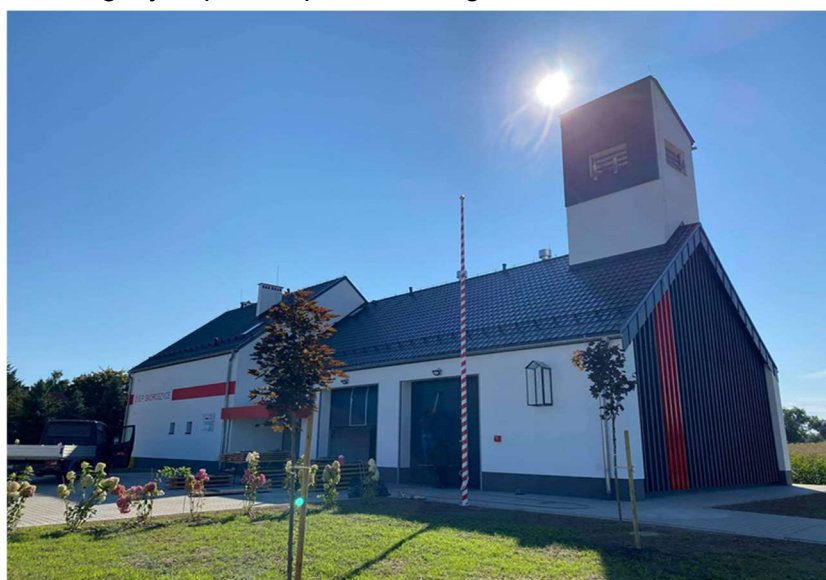
Nowo wybudowana remiza OSP Skoroszyce.
